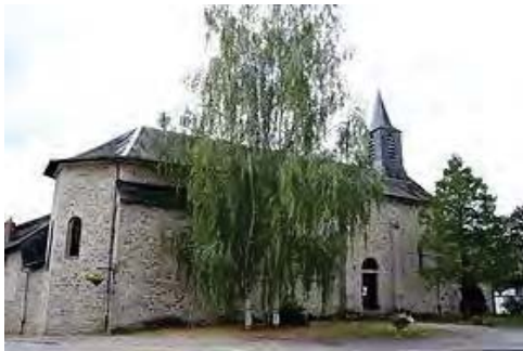
③ Église à Saint-Brice-sur-Vienne (distance à l'AER : 13,8km)
