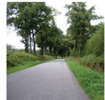
75-La D29 à proximité immédiate du site potentiel d'implantation
