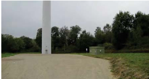
Poste de livraison existant au pied de l'éolienne 1 du parc de Saulgond-Lesterps
